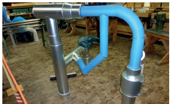
Rohrgestell mit Isolierungen
